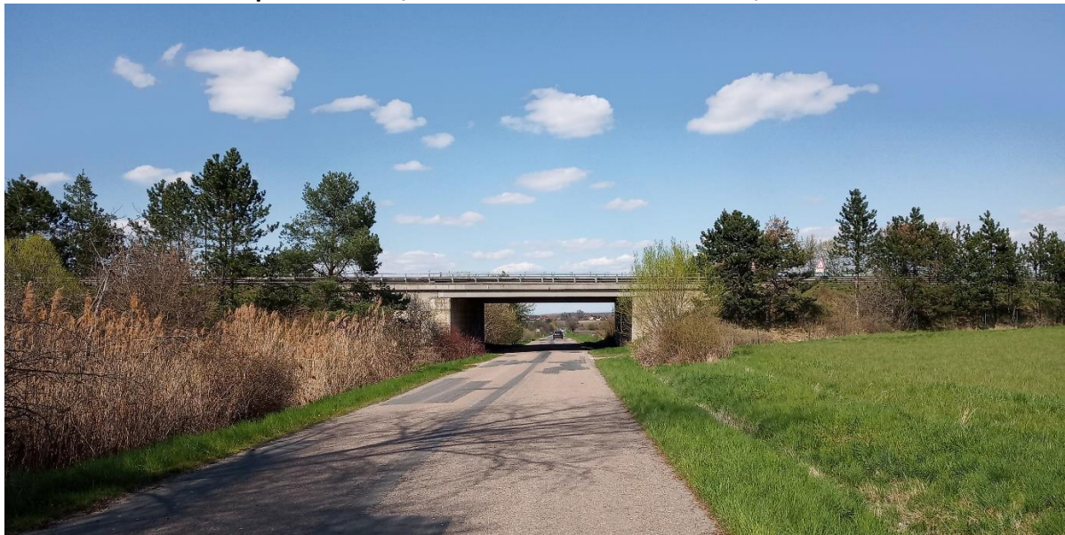
Obr. 46 Dálniční most přes silnici III/3308 Chrást - Velenka v km 21,8
