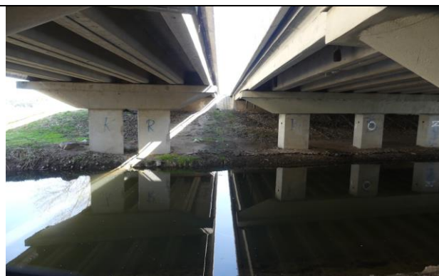
Průhled podmostím z levého břehu k pravému
