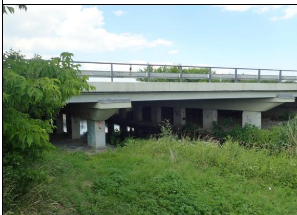
Celkový pohled na přemostění
