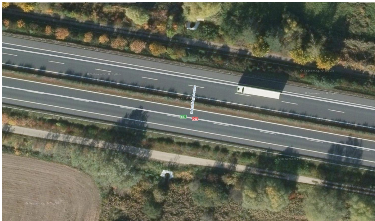
Obr. 22 Propustek (turbosider) převádějící Sokolečskou strouhu v km 37,51 přes těleso dálnice
