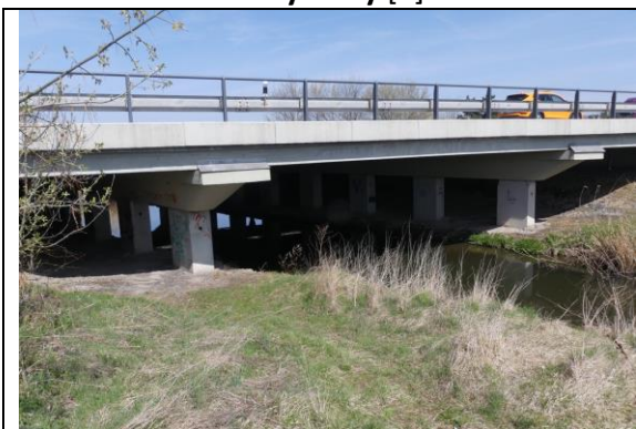
Přemostění Výrovky vícepólovým mostem
