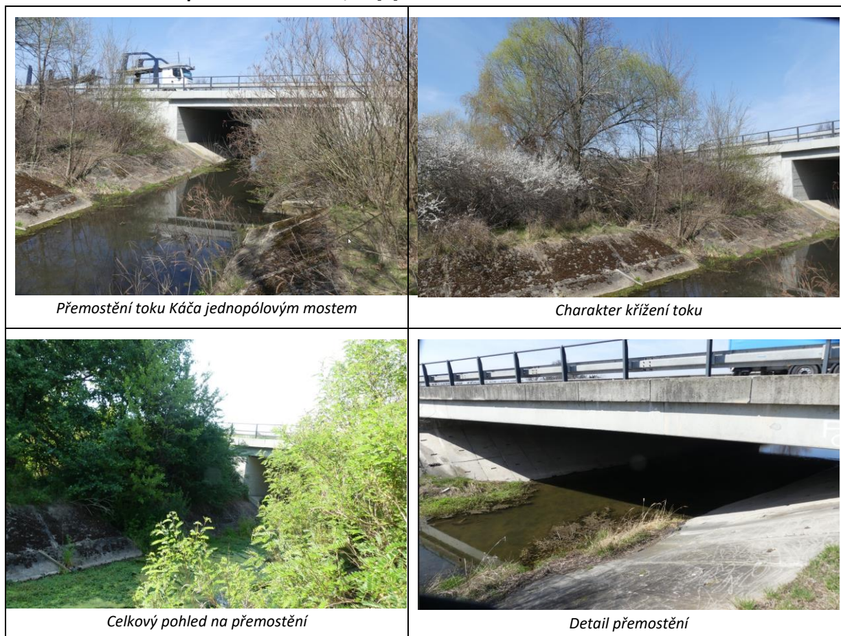
Obr. 20 Dálniční most přes Káču v km 33,93 [2]
