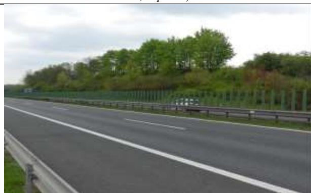
Průchod D11 zářezem v elevaci, pohled na porosty svahu zářezu kolem km cca 22,0 vpravo/jižně
