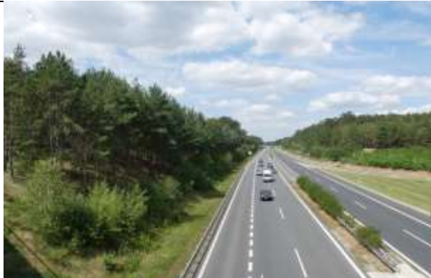
Výstup D11 z lesa Kersko-Bory, pohled z mostu MÚK se silnicí II/330 proti staničení
