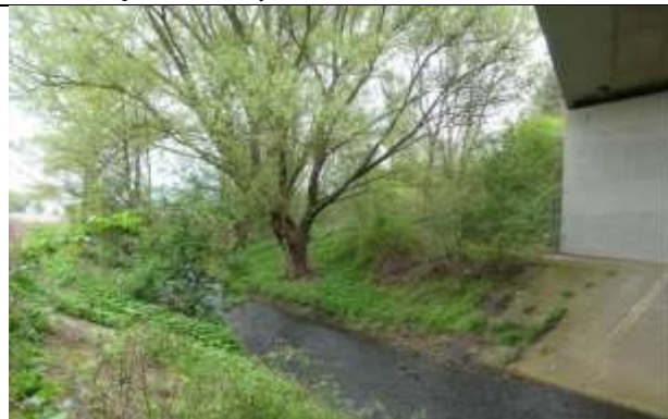
Křížení Výmoly (NRBK), km 14,1
