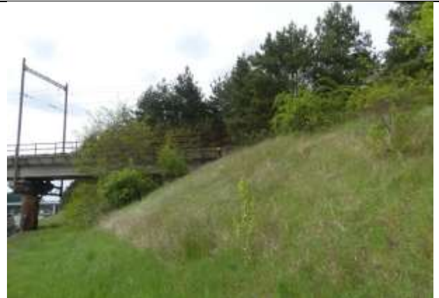
Xerofytní svah zářezu s vysychavými lody, km cca 25,9 (vlevo/severně, proti staničení)
