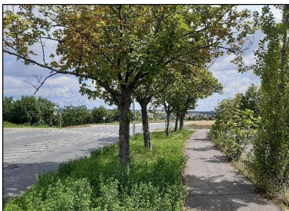
Obr.12: Stromořadí u točny autobusu v Čimicích (položka č. 35)
