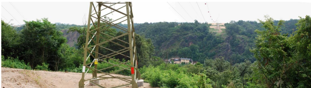
Obr. 3.22: Koridor Vltavy z levého břehu s přechodem elektrického vedení (Foto: Vorel, 2009)
