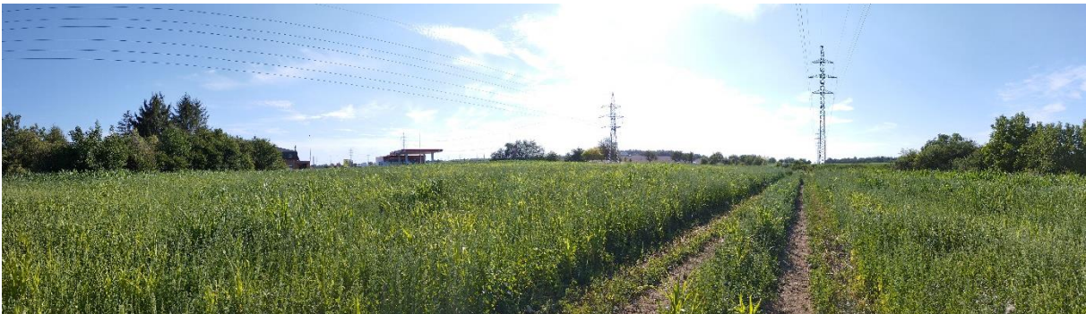
Obr. 3.16: Pohled na severovýchodní okraj PDoKP C/518 od Starého Suchdola. Prostorovou osou je zde silnice Kamýcká. V těchto místech bude NZ již v tunelu podcházejícím Suchdol. Krajina je zde plochá, otevřená, málo členěná, agrární, ovšem s výrazně suburbánním charakterem. (Foto: Kupka, 2022).
