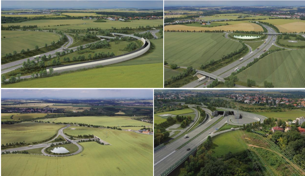
Obr. 2.3: MÚK Přední Kopanina, MÚK Horoměřice, MÚK Suchdol a MÚK Rybářka. Vizualizace zachycují re- álnou situaci složitějších úseků na trase 518 (MÚK) vč. výškového řešení. Pro posouzení vlivu na KR jsou však zásadní pohledy z terénu (z horizontu chodce, které jsou doloženy v samostatné přílohové části Dokumentace EIA.). Z vizualizací je zřejmé, že využití zářezů, tunelů a krajinařských úprav snižuje vliv NZ na krajinnou scénu (Po- skytuto objednatel).
