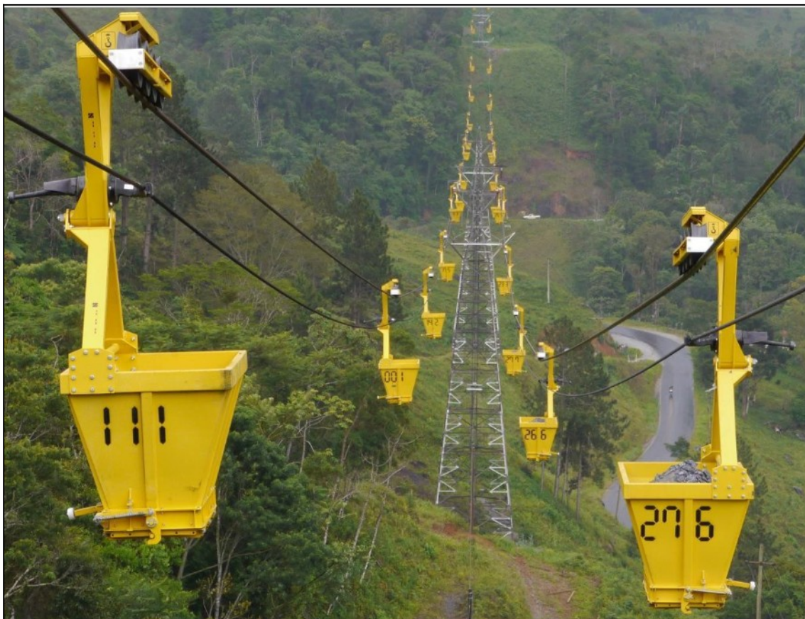
Obr. 11 Materiálová lanovka pod korunami stromů (ilustrační foto)
