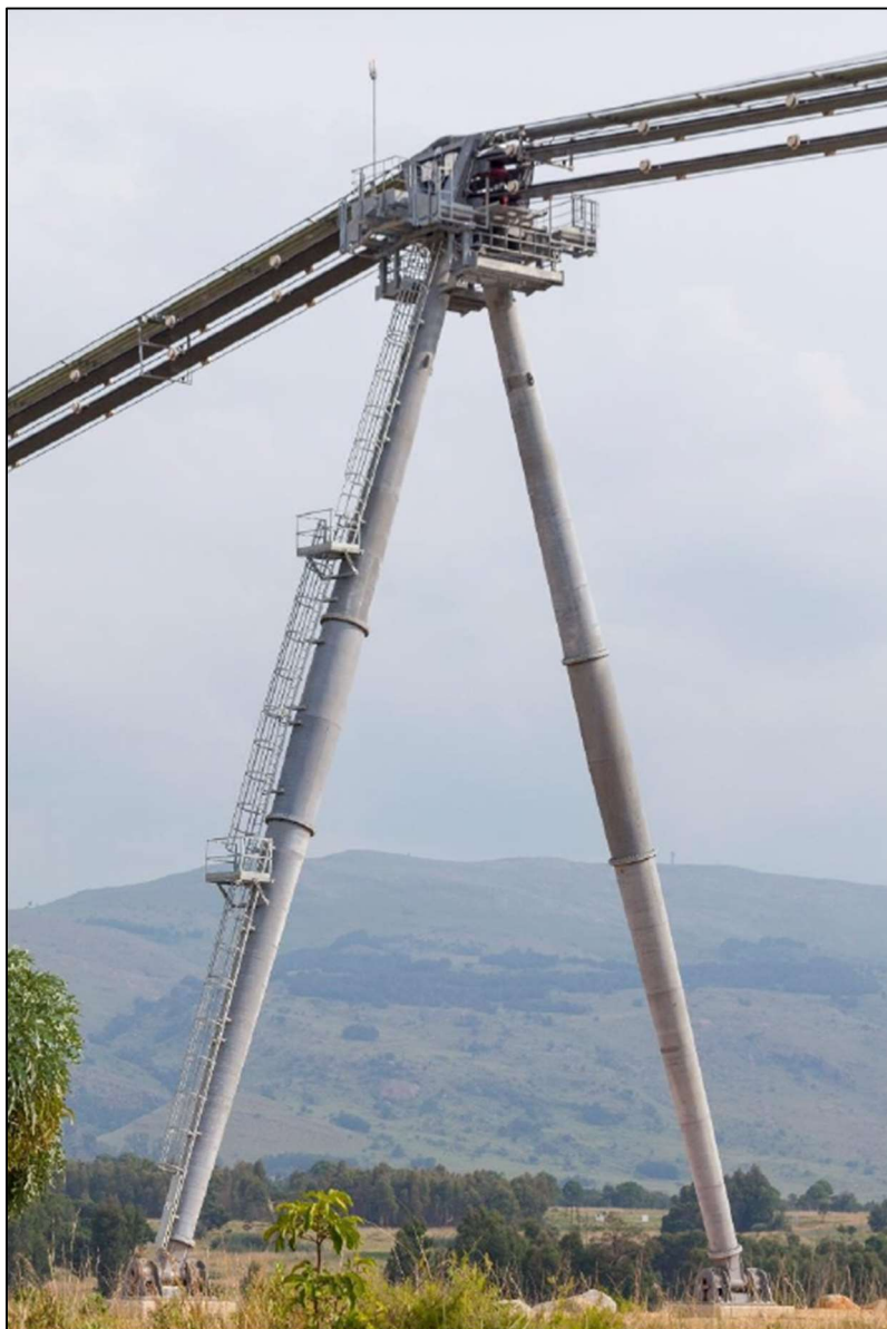
Obrázek 15: RopeCon - typická věž s A-rámem (ilustrativní charakter)
