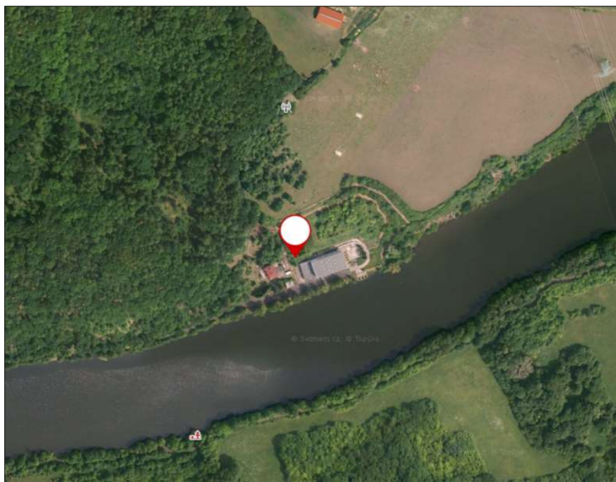
Obrázek 40: Čerpací stanice Mikulovice na levém břehu Ohře (50.3784403N, 13.2424650E)
