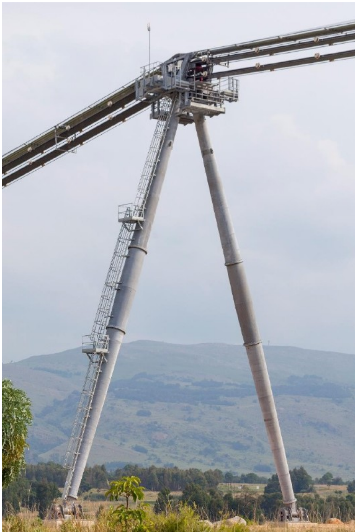
Obr. 9: Věž s A-rámem (DOPPELMAYR 2023)
