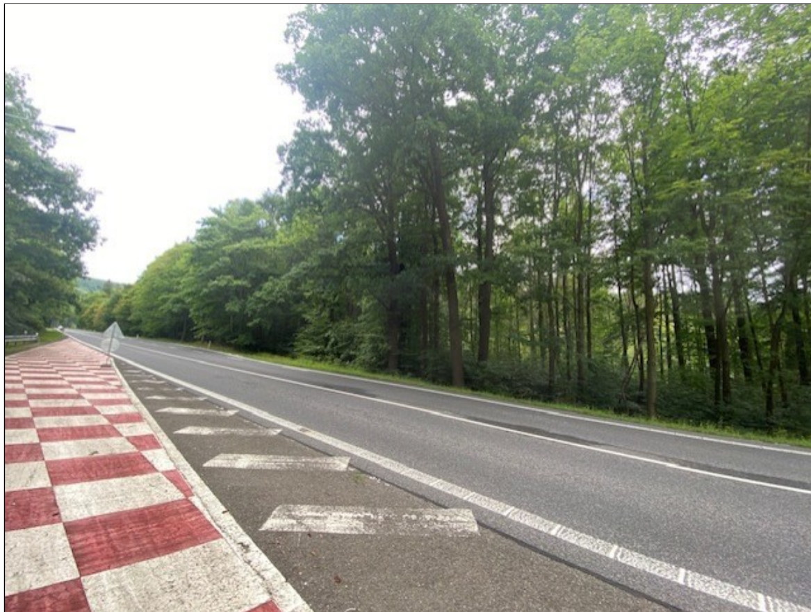
Foto 3: Silnice I/8 v místě křížení se závěsným pásovým dopravníkem z HZ do Překladiště v lokalitě Dukla
