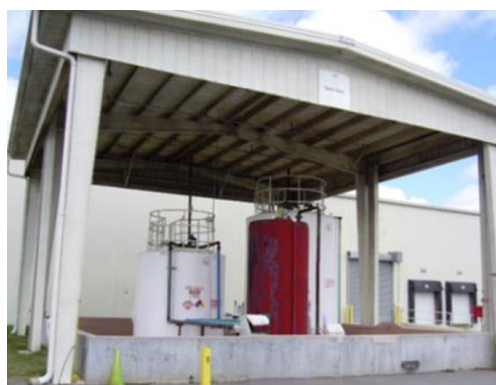
Obrázek 8 - Příklad zastřešeného skladového hospodářství kapalných látek
