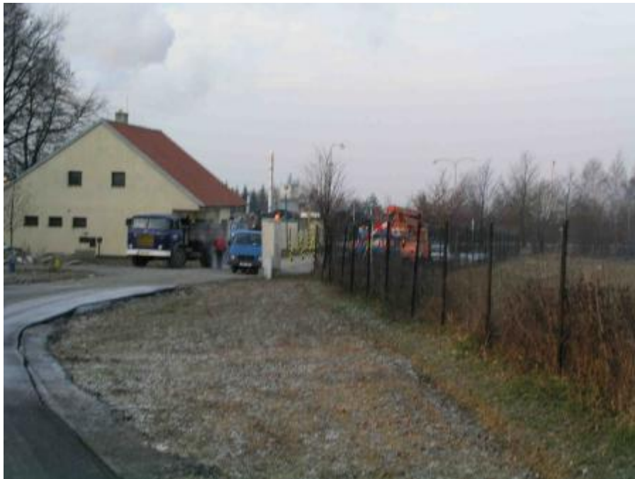
Obr. 3: Stávající provozní budova u vjezdu do areálu skládky a obslužná komunikace
