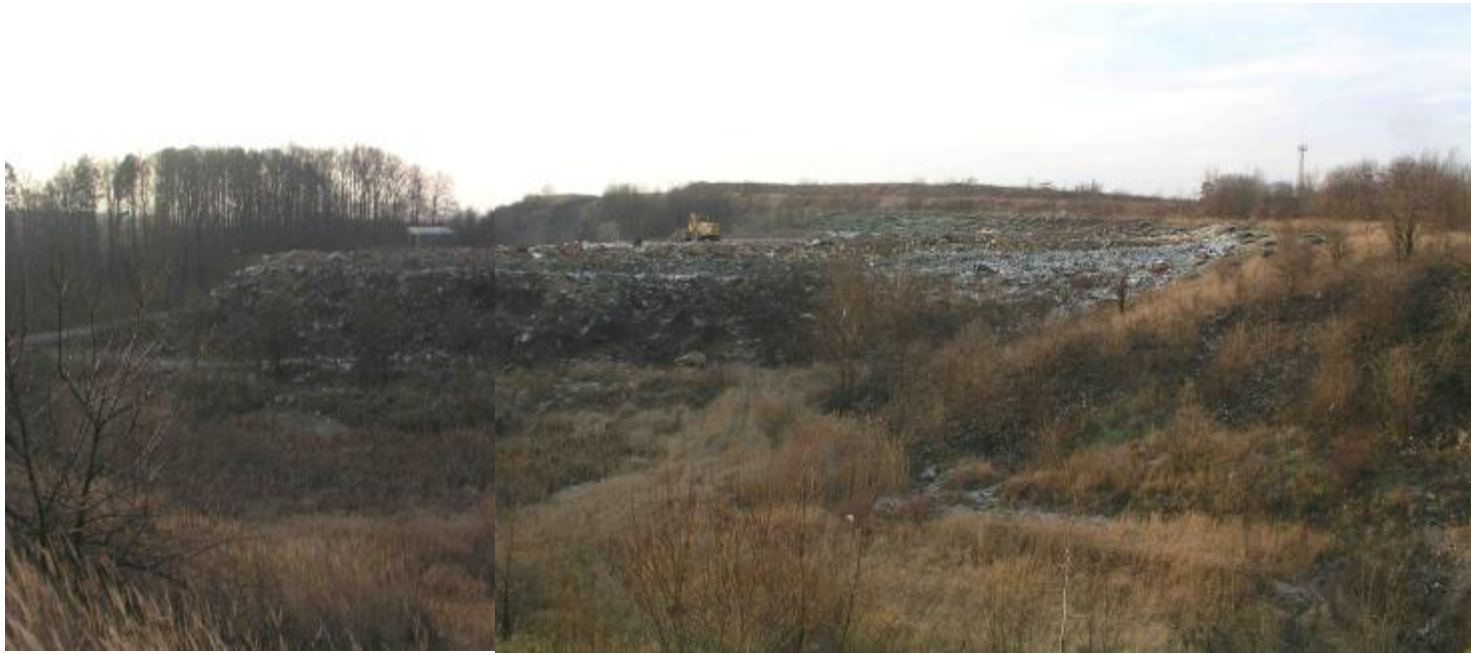
Obr. 1: Celkový pohled – v přední části snímku erozní rýha, místo pro 2. etapu skládky S-OO Bělotín, v zadní části snímku je viditelné čelo 1. etapy skládky
