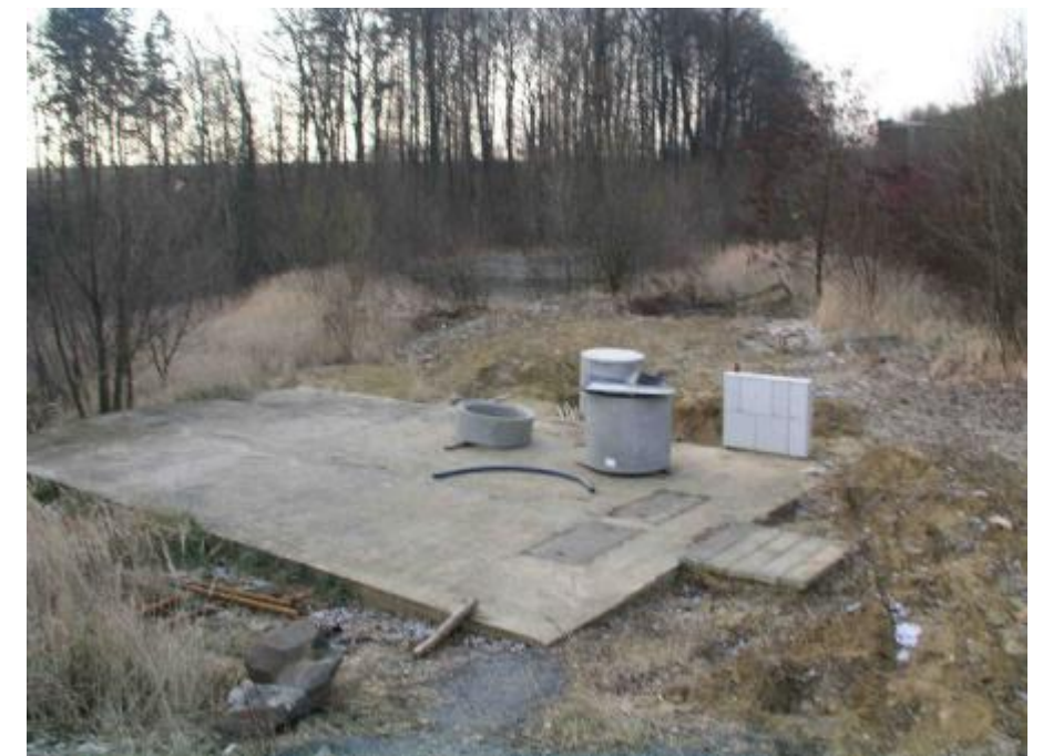
Obr. 5: Uzavřená jímka průsakových vod ze skládky
