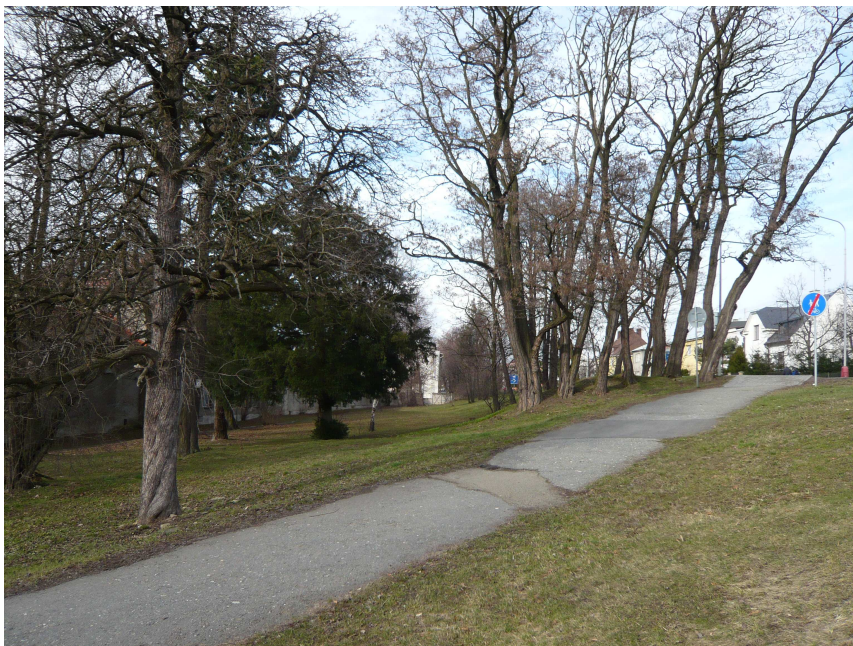
Foto D.1 Pohled na násep tělesa silnice I/46 (ulice Olomoucká)
