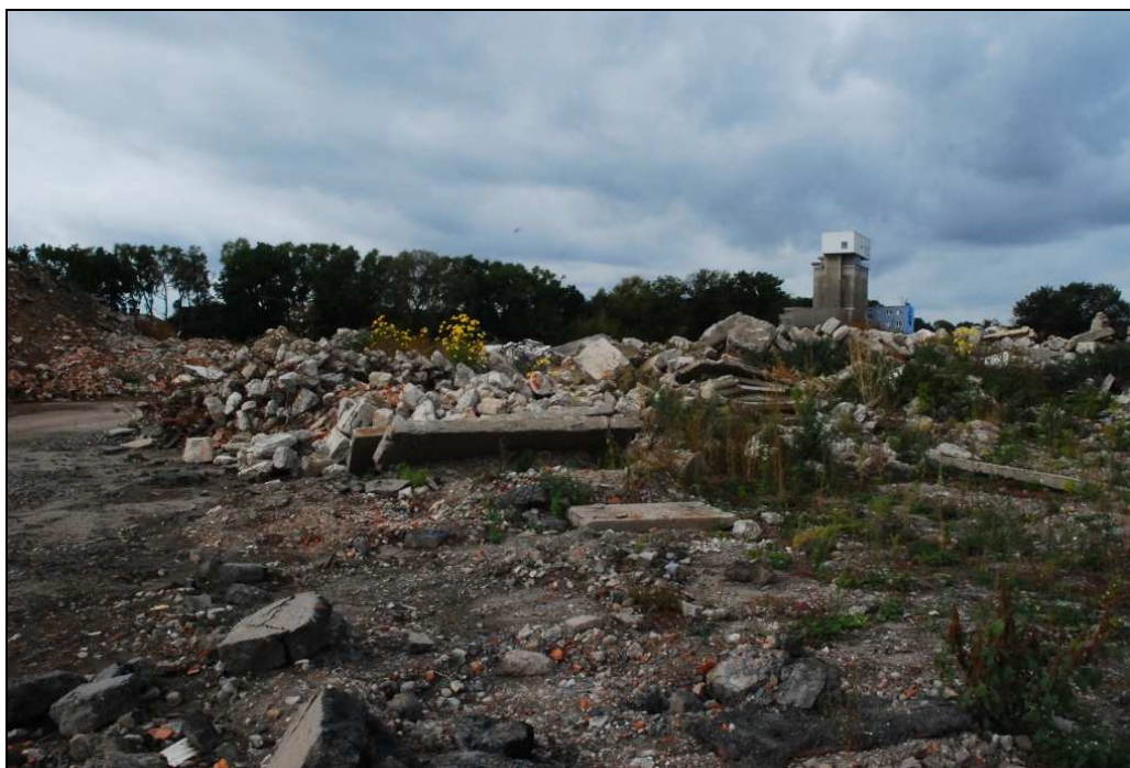
Obr. 8. Současný stav lokality po demolici původních objektů
