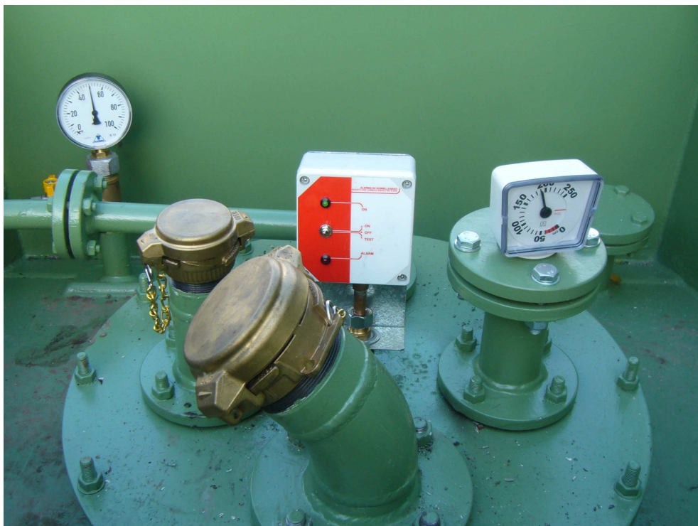
Obrázek č. 4 – Detail standardního víka nádrže
