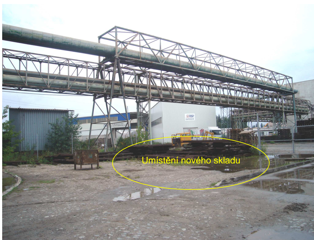
Obrázek č. 4 – Parcela pro umístění nového skladu chemikálií a hořlavin
