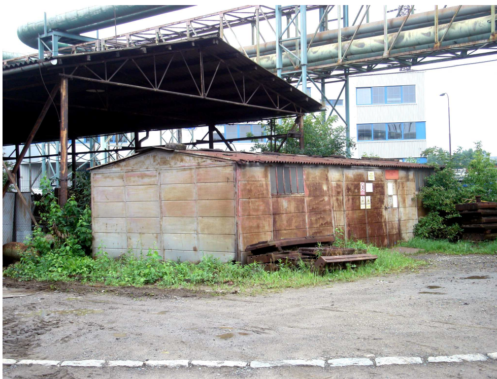
Obrázek č. 3 – Pohled na stávající nevyhovující skladovací objekt
