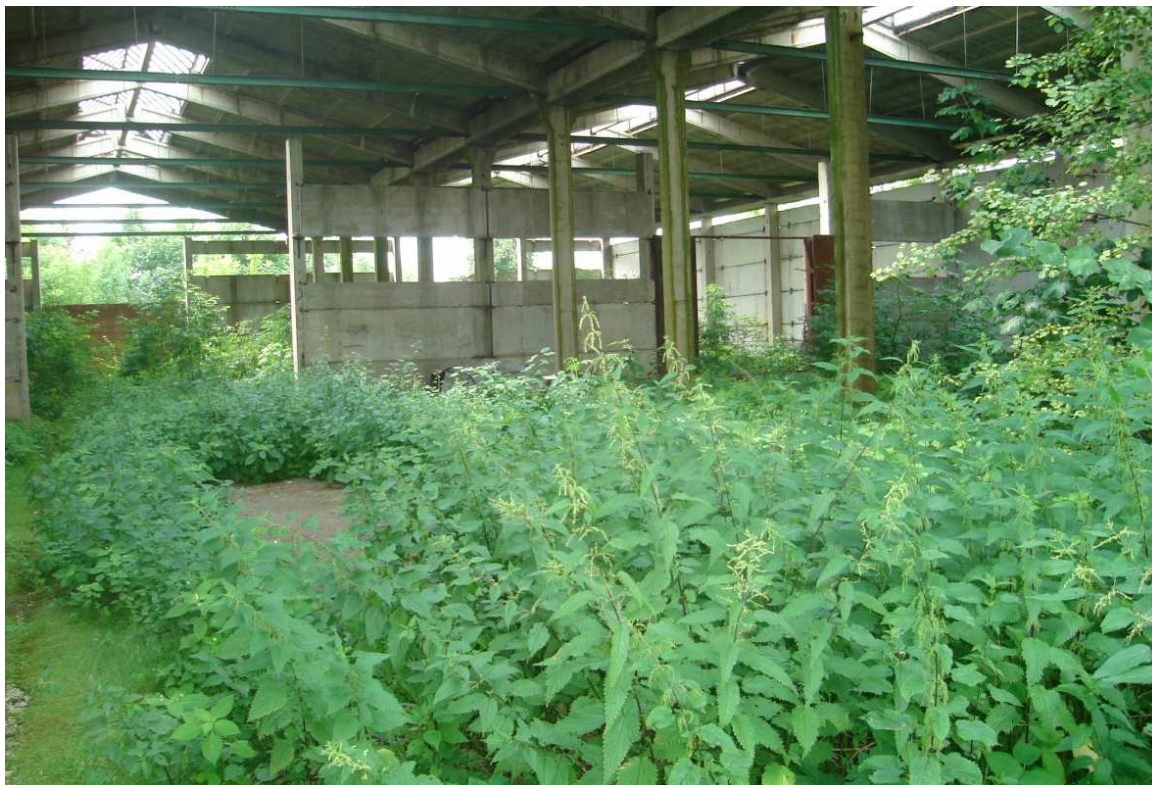
Obrázek č. 4 – Pohled do interiéru stávající stavby
