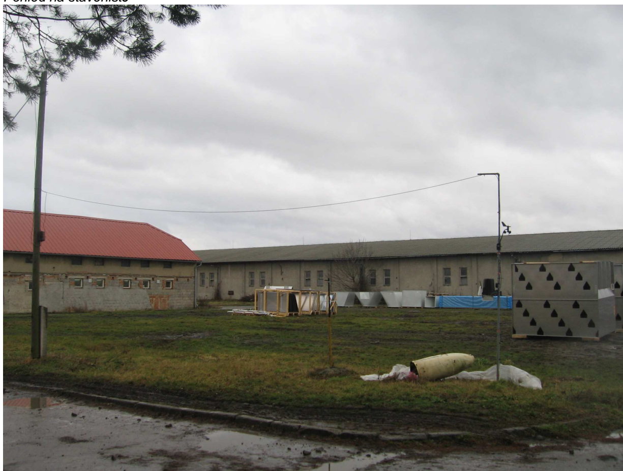
Pohled na staveniště
