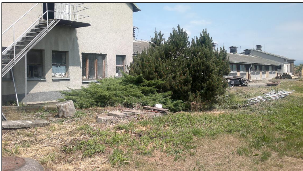
Foto 3: Pohled na místo stavby od jihovýchodu.
