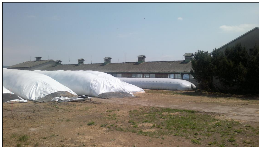
Foto 4: Pohled na místo stavby od jihozápadu.
