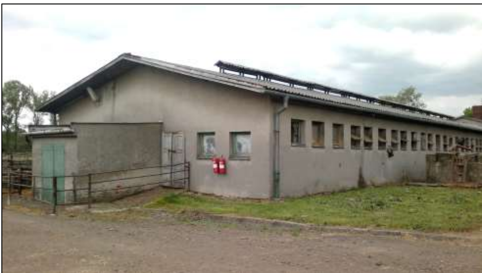
Foto 3: Objekt stáje parc.č. 1378 Rostlinný pavilon I. určený k demolici. Pohled od severu.
