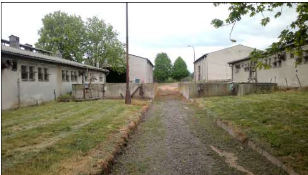
Foto 1: Objekty stájí parc.č. 1375 a 1374 v popředí a jímky na kejdě určené k demolici. Pohled od severovýchodu.
