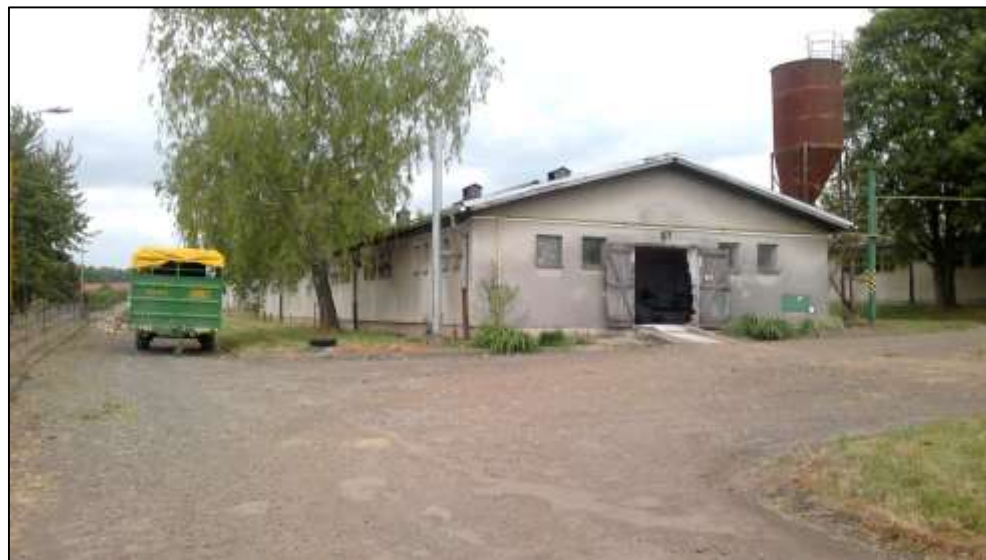
Foto 2: Objekt stáje parc.č. 1375 určený k demolici. Pohled od severovýchodu.
