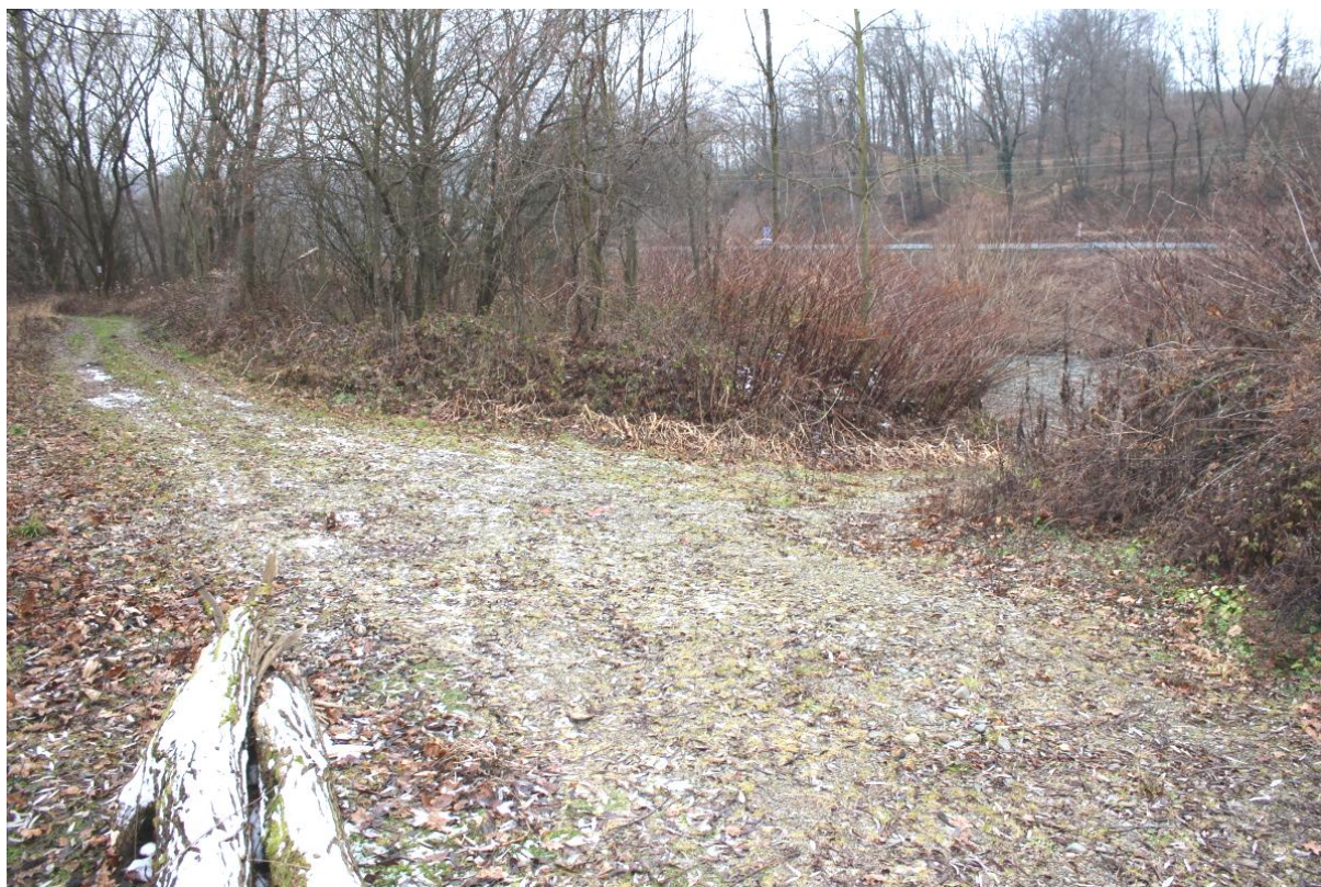
Obr. B.1.6: Stávající účelová cesta a sjezd do koryta v místě budoucího nátoku do obnoveného koryta (pohled po vodě), prosinec 2016
