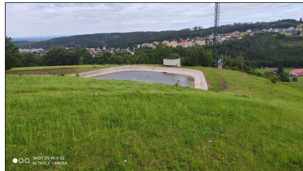
Obr. 4: Vodní nádrž – zásobník vody pro zasněžování. Pohled od východu.
