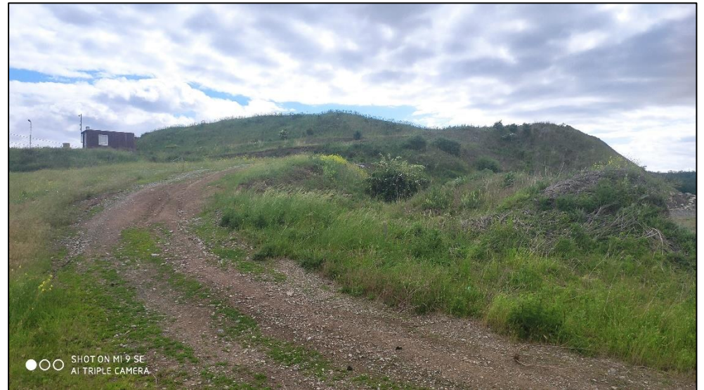
Obr. 6: Probíhající terénní úpravy. Pohled od západu.
