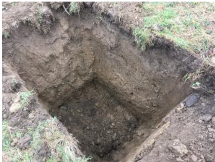
Obr. č. 4: Hloubení výkopu J-2 na pozemku p.č. 2682/1 (prostor projektované rýhy a sběrné studny)
