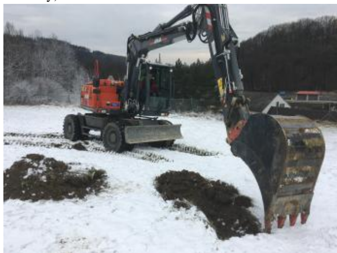
Obr. č. 4: Hloubení výkopu J-2 na pozemku p.č. 2682/1 (prostor projektované rýhy a sběrné studny)
