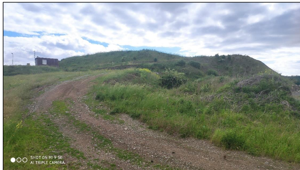
Obr. 6: Probíhající terénní úpravy. Pohled od západu.
