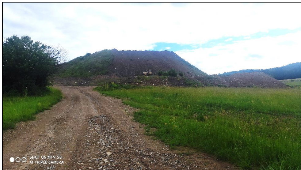
Obr. 5: Probíhající terénní úpravy. Pohled od jihu.
