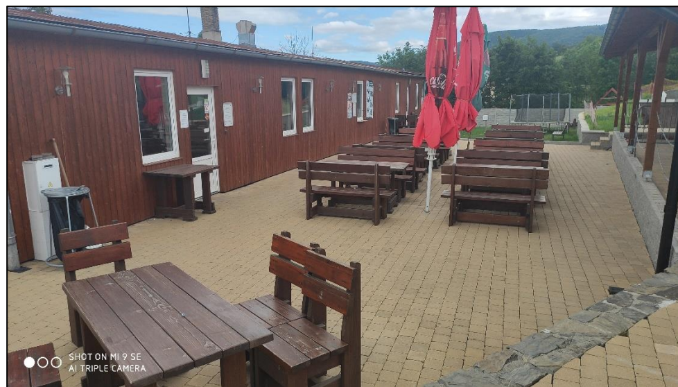
Obr. 6: Zázemí SKIareálu. Pohled od jihu.
