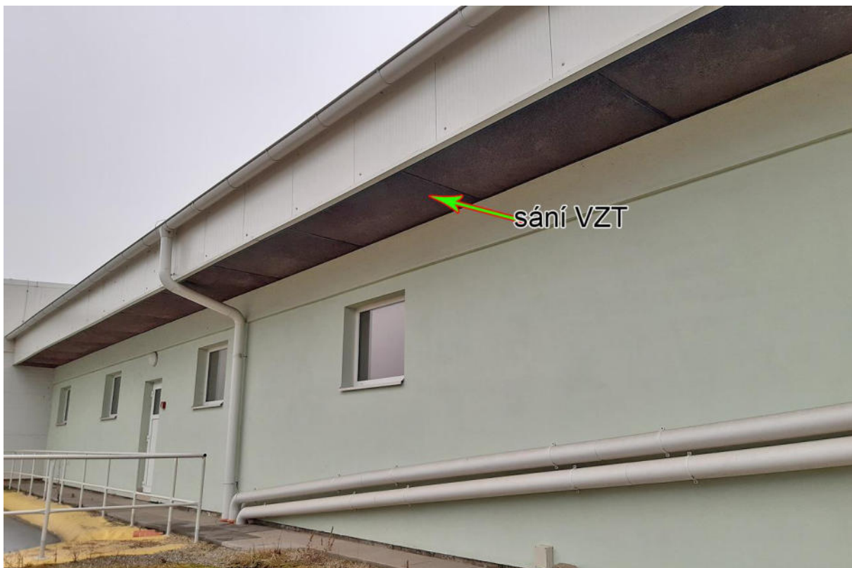
OBR. 5 pohled na sání VZT
