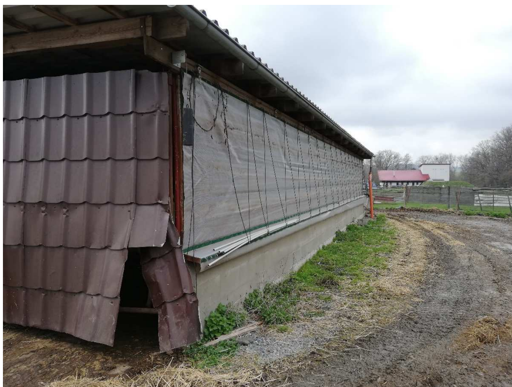
Pohled na stáj určenou k demolici
