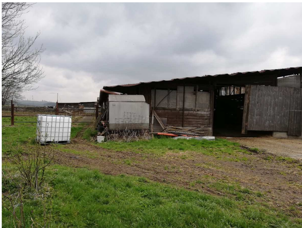
Pohled na stáj určenou k demolici
