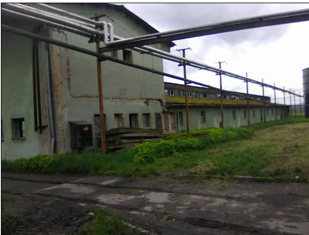
Obrázek 6: Výhledově demolovaný objekt stávajícího zemědělského areálu (dochovna prasat), situovaný v místech plánované stáje, jenž je součástí záměru
