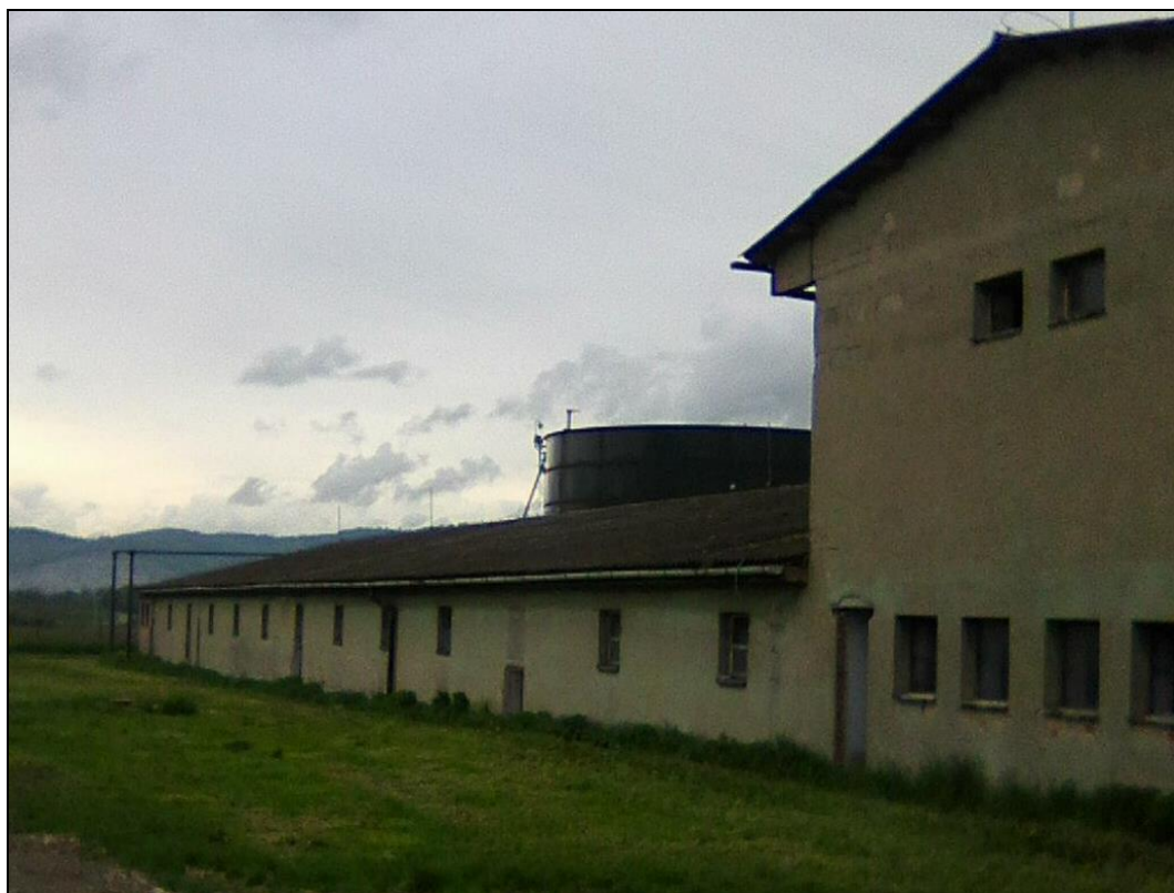
Obrázek 7: Objekt (dochovna prasat) stávajícího zemědělského areálu, výhledově demolovaný, v místech plánované stáje, jenž je součástí záměru
