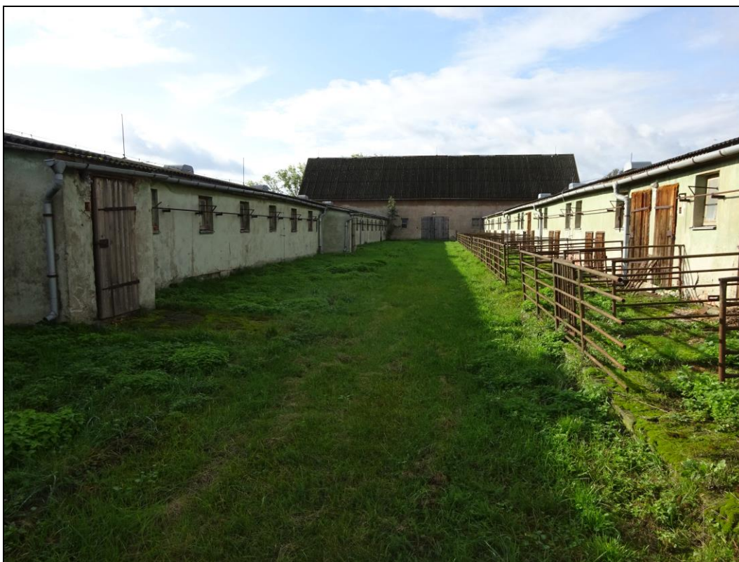
Obrázek 4: Pohled na již zdemolovaný objekt (porodna prasat – stav před demolicí)
