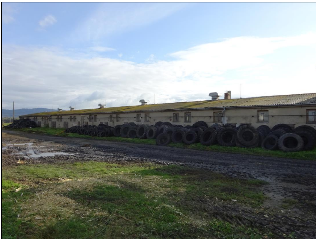
Obrázek 5: Pohled na již zdemolovaný objekt (porodna prasat – stav před demolicí)
