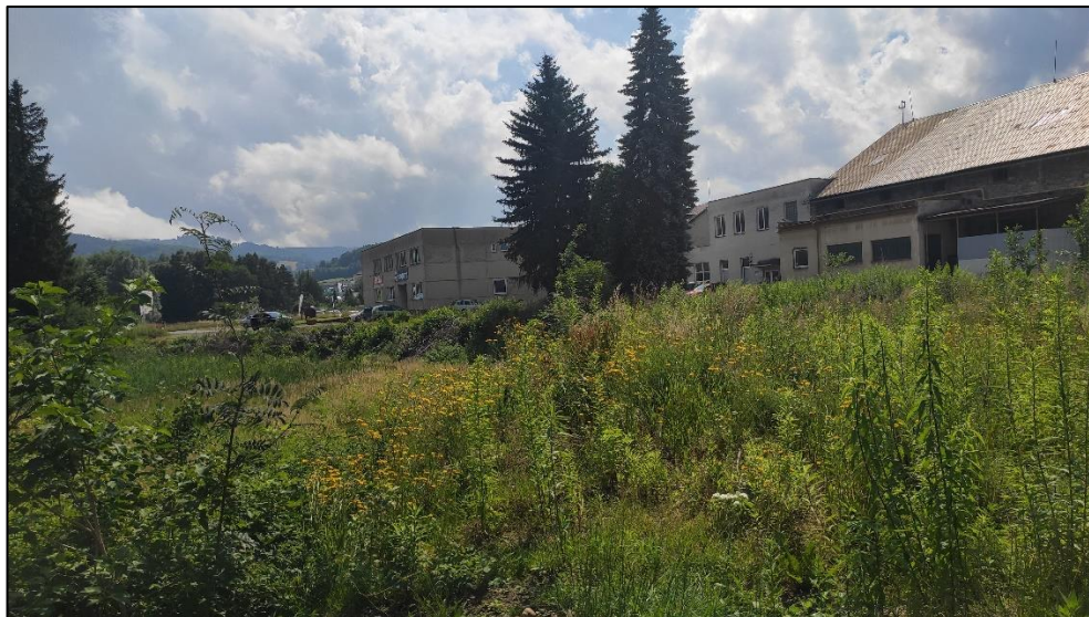
Obr. 3: Jižní břeh bývalých nádrží s objekty areálu Moravolen.
