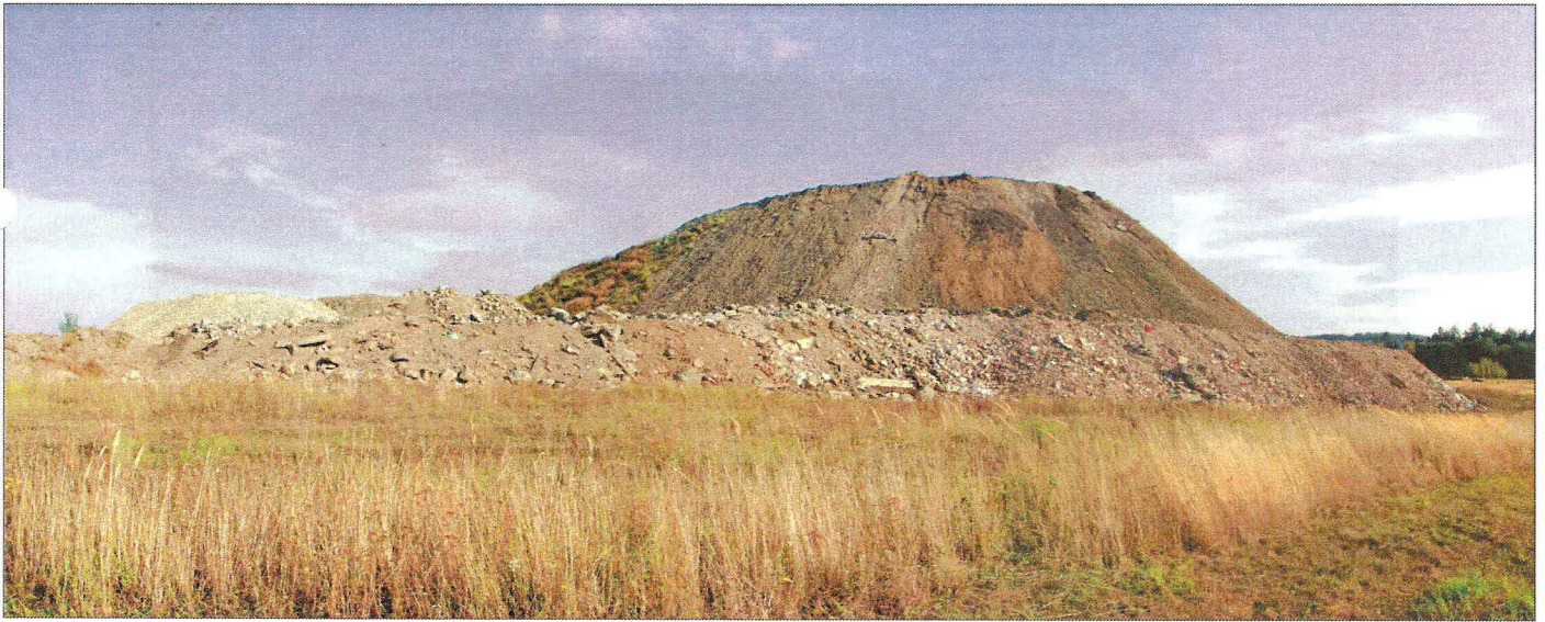
Foto – 7 Pohled na deponii od jihu.
