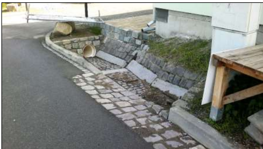
Foto č. 3: Propustek před parkovištěm (Plocha 2).
