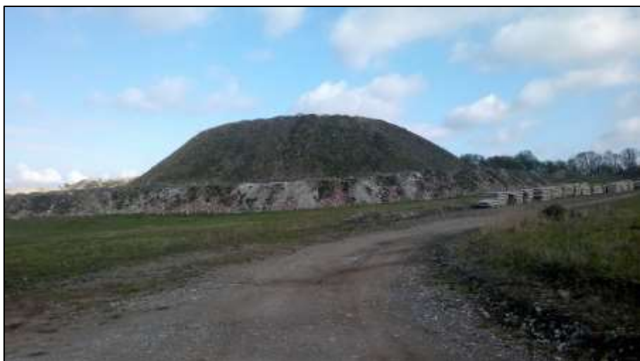
Foto č. 7: Pohled na probíhající terénní úpravy od jihu (Plocha III.).
