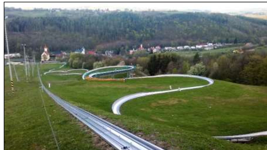
Foto č. 6: Celkový pohled na bobovou dráhu (Plocha 6 a 7).
