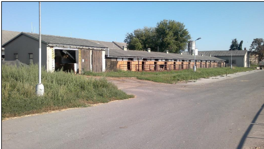
Foto č. 1: Celkový pohled na stávající stáj od jihu.
