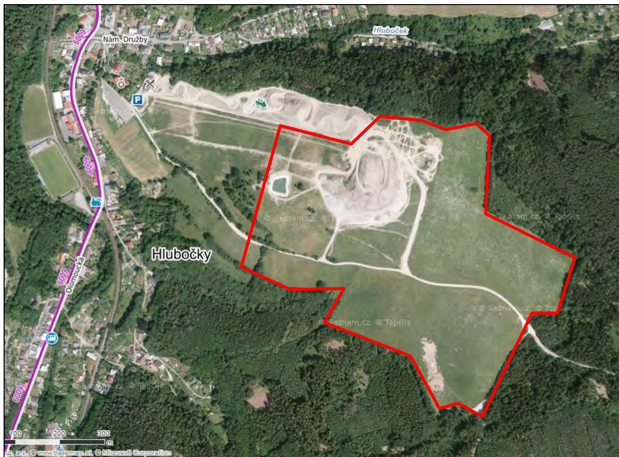
Obr. 1: Letecký snímek zájmové lokality v horní části Skiareálu Hlubočky s patrnou navážkou
