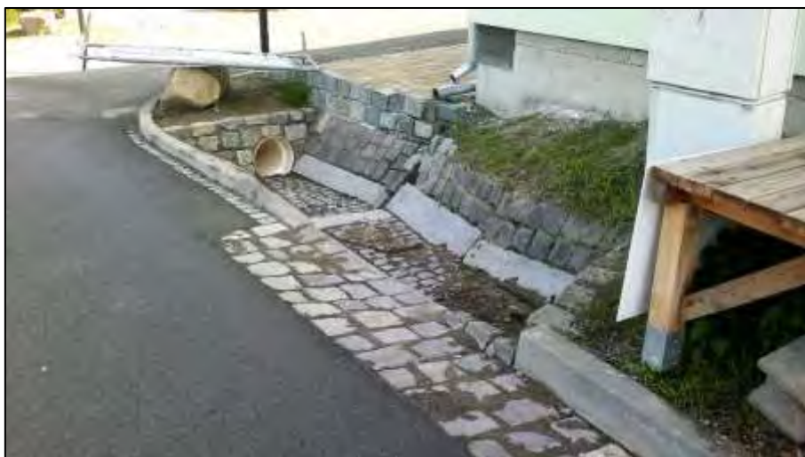
Foto č. 3: Propustek před parkovištěm (Plocha 2).
