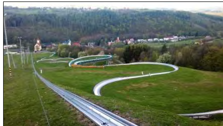
Foto č. 6: Celkový pohled na bobovou dráhu (Plocha 6 a 7).
