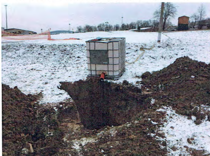
Obr. č. 5 a 6: Vsakovací zkouška na výkopu J-2
