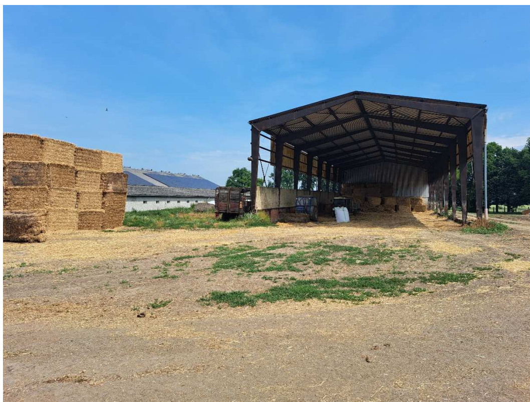
Pohled na místo stavby nové stáje
