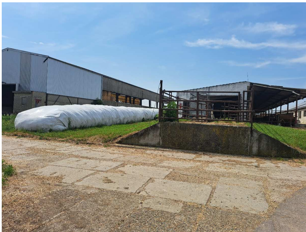
Pohled na stavby určené k demolici
