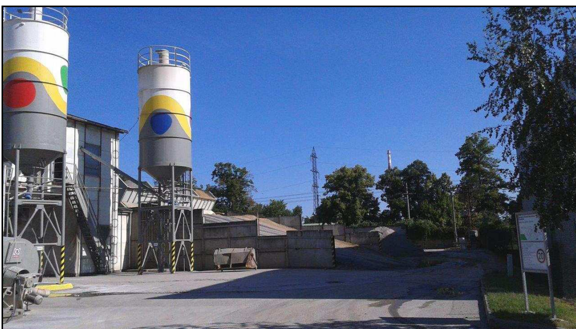
Obr. 3: Pohled do areálu stávající betonárny (foto autor)
