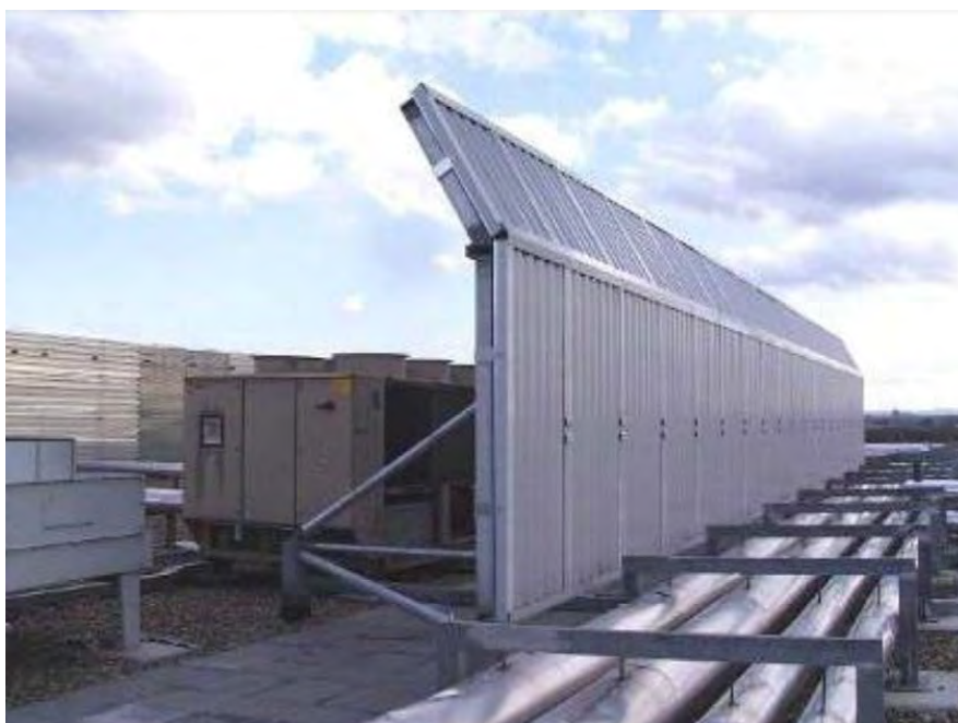
Obr. 1: Referenční ukázka možného provedení akustické clony
