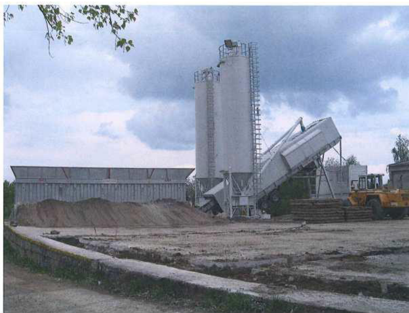
Obrázek č. 1 Betonárka – ilustrační foto
