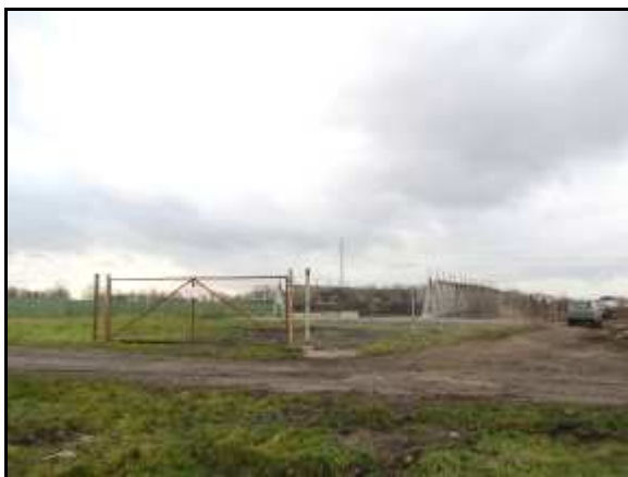
Areál plánované dekontaminační plochy
