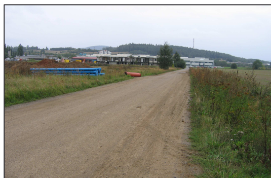
Obr. č. 4: Stávající příjezdová komunikace k záměru
