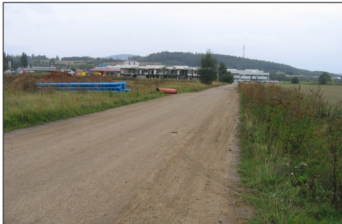
Obr. č. 4: Stávající příjezdová komunikace k záměru
