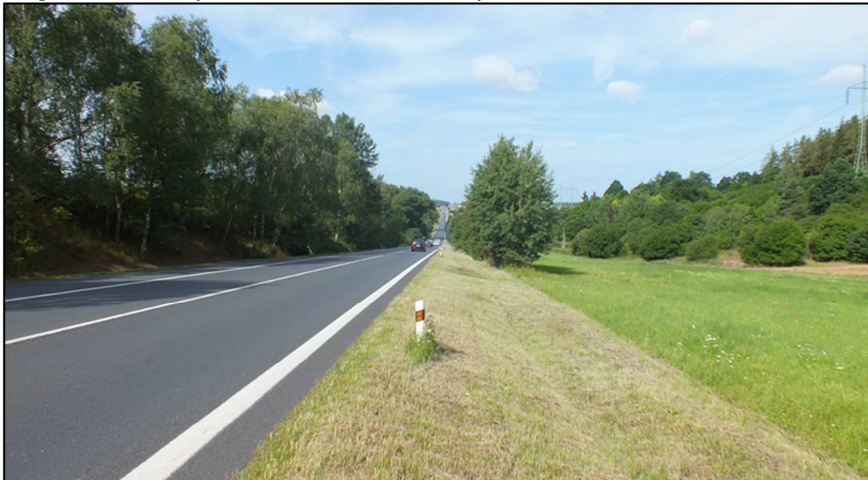
Fotografie 2 Silnice I/6 – pohled od Krušovic ve směru na Krupou
