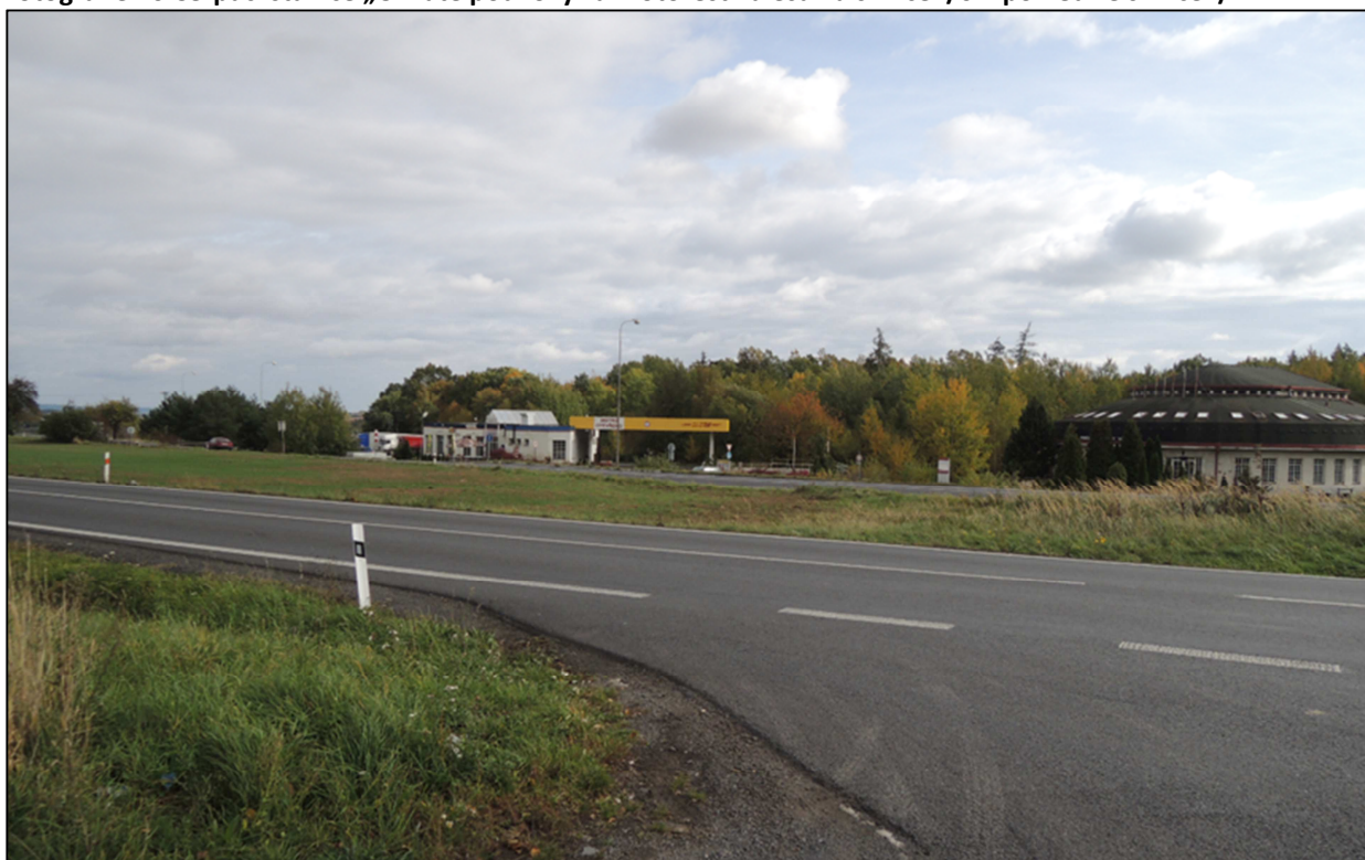
Fotografie 16 Čerpací stanice „U Zlaté podkovy“ a motorest Zálesák u silnice I/6 – pohled ze silnice I/27
