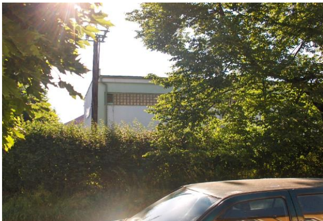
Obrázek č. 22: U Elektrárny – pohled na rozvodnu
