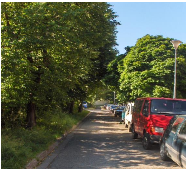
Obrázek č. 23: Pohled do ulice U Elektárny
