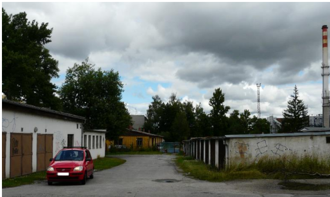
Obrázek č. 27: Náhled za garáže, kde bude proveden výkop a uložení podzemního el. vedení
