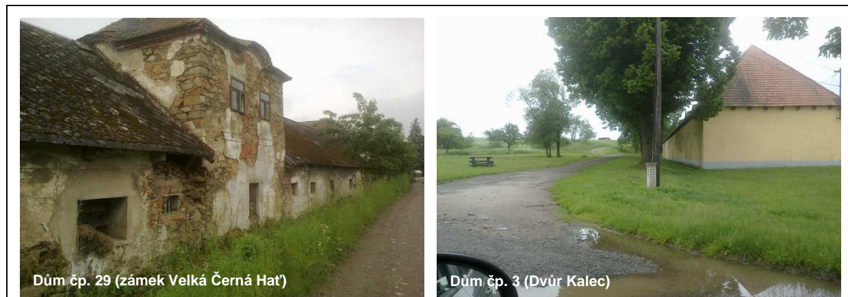
Obrázek č. 36: Stav objektů v blízkosti dotčených komunikací
