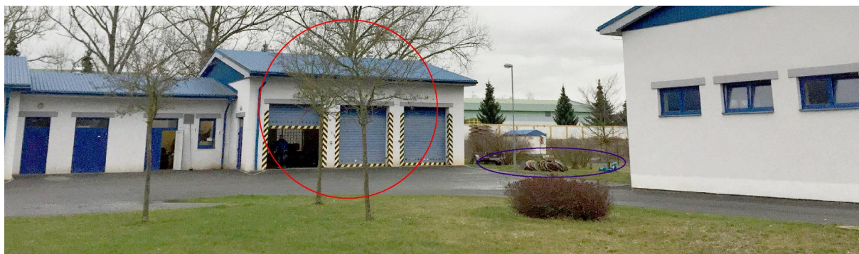
Místo realizace záměru ( červená hala pro technologii, modrý prostor pro zásobní nádrže)
