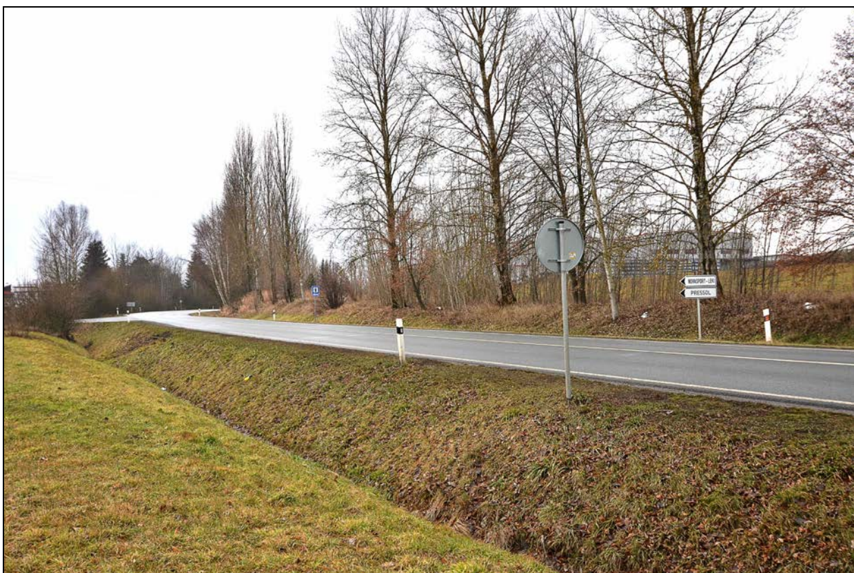
Pohled na umístění haly ze silnice směr Tachov
