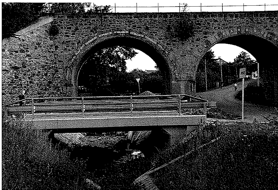
Obr. č. 6 Technické objekty v rozestavěnosti na biokoridoru Ejpovického potoka
