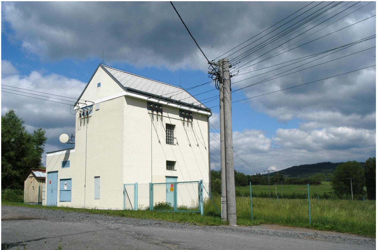
Objekt stávající trafostanice
