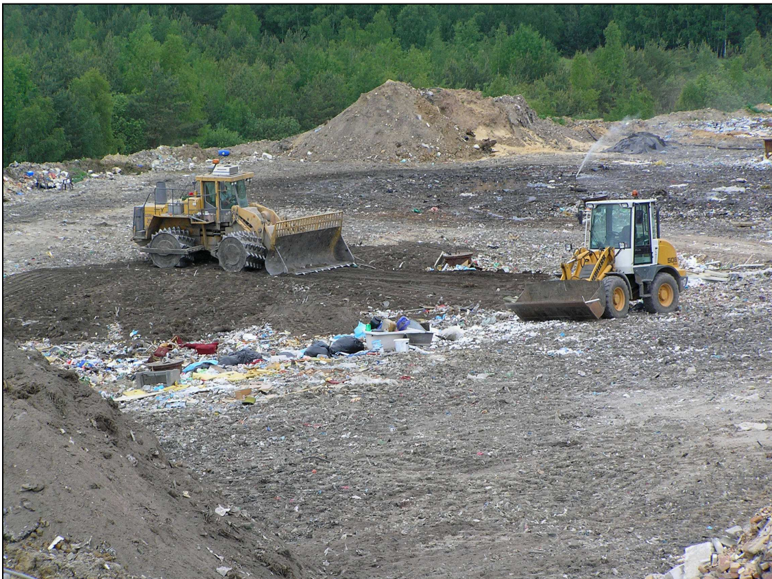
fotodokumentace č. 4 Kompaktor a buldozer při práci na terénních úpravách povrchu stávající kazety skládky Chotíkov
