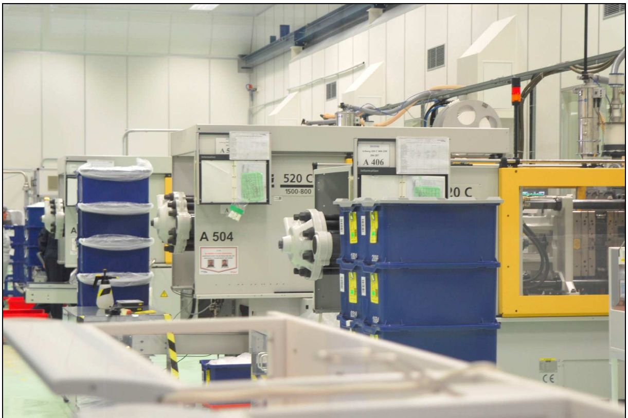
Technologické vybavení ve stávající hale
