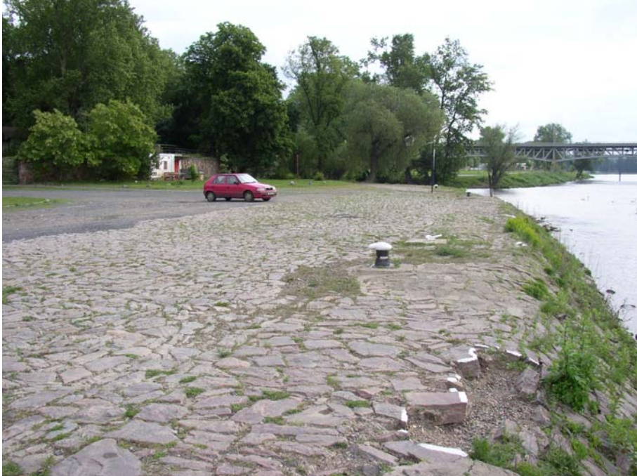
Obr. 3 Pohled na zájmovou plochu – ve směru k silničnímu mostu přes Labe
