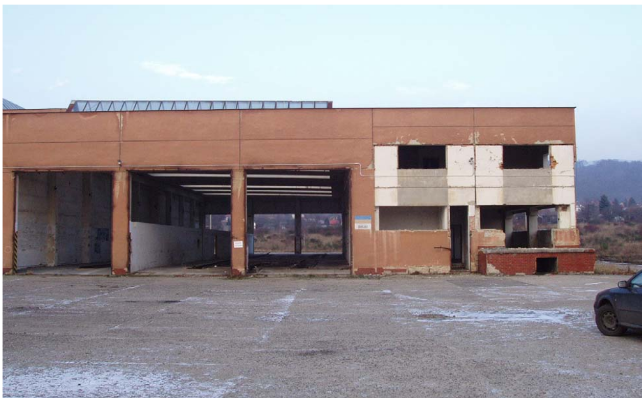
Pohled 1 a 2: Pohledy na opuštěné haly v bývalém areálu Vodních staveb v Litvínově – Chudeříně od jihu. Záměrem investora – společnosti Simona Plast – Technik Litvínov je rekonstruovat haly a umístit v nich plastikářskou výrobu.
