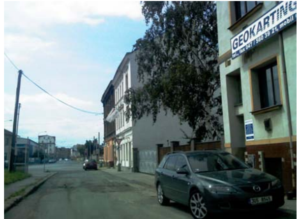
Obr. 7 Pohled na vstup do areálu z ul. Tovární (z obr. je zřejmé, že na areál CWS – administrativní budovu - bezprostředně navazuje obytný dům s restaurací v přízemí).
