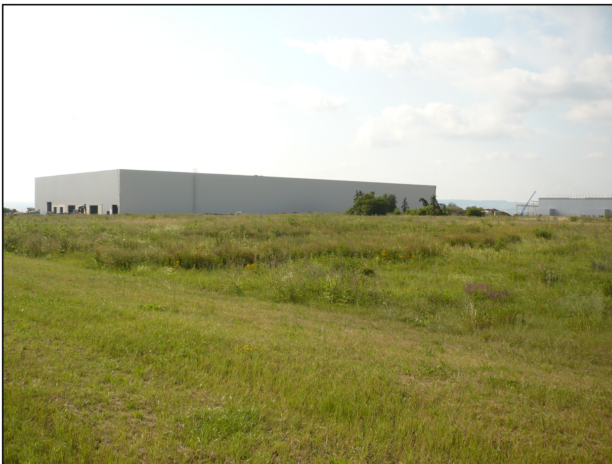
Obr. 6: Pohled na zájmový pozemek pro rozšíření závodu Žatec Plant od severovýchodu
