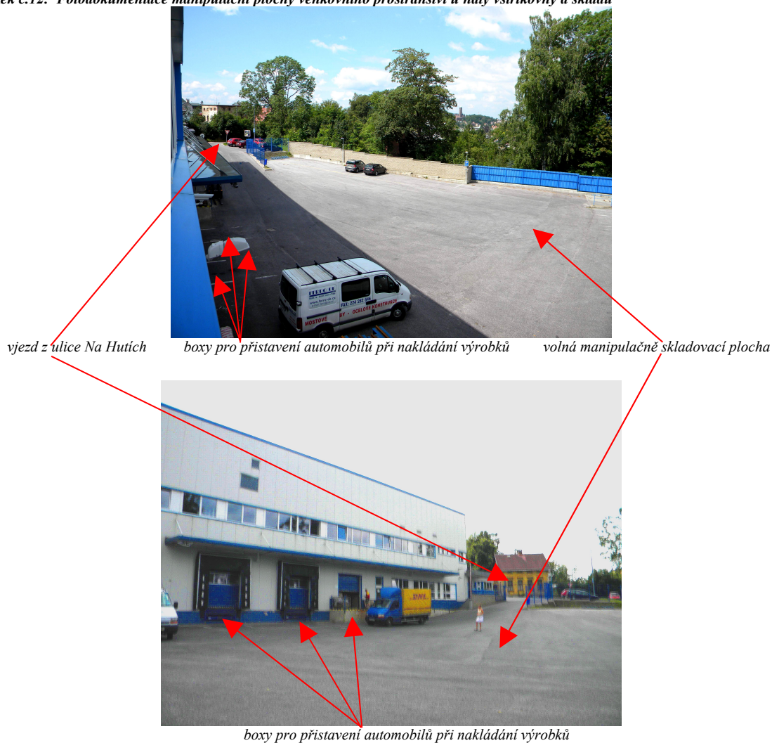
obrázek č.12: Fotodokumentace manipulační plochy venkovního prostranství u haly vstříkovny a skladu
