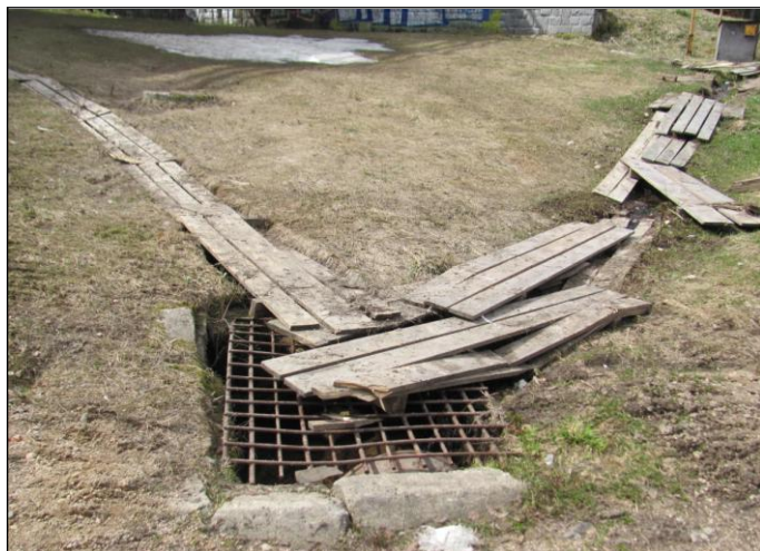
Foto č.4 Dnes pouze nedokonale podchycené povrchové vody přitékající do prostoru stávající červené sjezdovky
